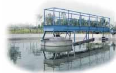
Depurazione di acque reflue attraverso processo chimico-fisico (Coagulazione e Flocculazione)
